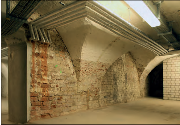
Abb. 3 Greifswald, Lange Straße 82. Kellergeschoss des Haupthauses. Die Südseite der 0,86 m dicken mittelalterlichen Nordmauer wird zu großen Teilen durch ein barockes Kreuzgratgewölbe verdeckt. Ganz links der Durchgang zum ebenfalls gewölbten Keller des an der Fischstraße gelegenen Seitenflügels. Blick nach Nordosten. Foto: A. Lutze (2016)
