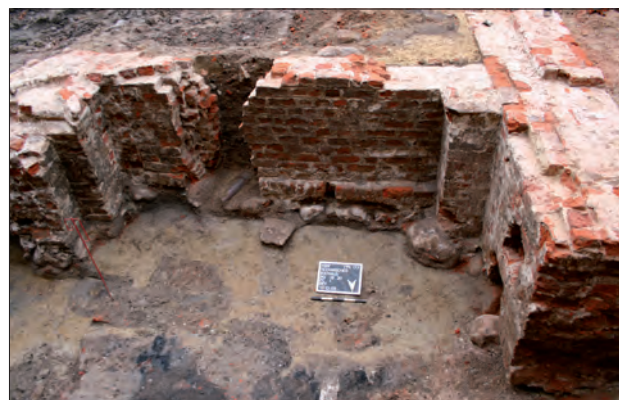
Abb. 31 Greifswald, Markt 15-19. Keller eines frühneuzeitlichen Anbaus auf dem Grundstück Markt 15. Die Südmauer entstand im 16. Jahrhundert, etwas später erhielt der Keller eine neue, dickere Ostwand und ein Kreuzgratgewölbe. Blick nach Süden. Foto: G. Schindler / P. Kaute (2009)
