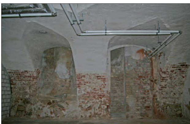
Abb. 8 Greifswald, Lange Straße 82. Mittlerer Bereich des Gewölbekellers unter dem Vorderhaus. Detail zu Abb. 7: Zum Fischmarkt hin gab es verschiedene Kellerfenster, deren Öffnungen von Stichkappen eingefasst waren. Blick nach Süden. Foto: D. Brandt (2014)
