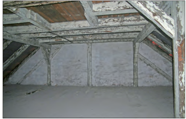
Abb. 11 Greifswald, Lange Straße 82. Östliches Drittel des Oberdachs über dem Vorderhaus. Allein der obere, flache Teil dieses Mansarddachs entspricht in seinen Dimensionen einer vollständigen Dachkonstruktion auf einem mittelgroßen Haus. Abgesehen von dem doppelten Stuhl ist am oberen Bildrand die Öffnung für einen der Schornsteine gut zu erkennen. Blick nach Osten. Foto: D. Brandt (2014)
