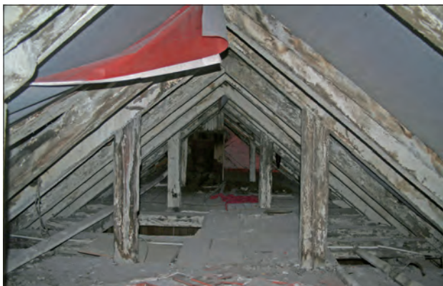
Abb. 13 Greifswald, Lange Straße 82. Oberdach des Vorderhauses. Das Lastenrad eines Aufzuges befand sich in der obersten Dachebene, die Pfosten für seine Befestigung sind bis heute erhalten geblieben. Diese Vorrichtung diente zum Warentransport durch die einzelnen Geschosse des Hauses (vgl. auch Abb. 12), dessen Dach genügend Lagerraum bot. Blick nach Osten. Foto: D. Brandt (2014)
