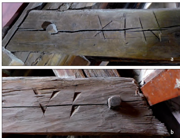
Abb. 5 Greifswald, Knopfstraße 20. Abbundmarkierungen im römischen System. Die Zählzeichen bestehen an der nördlichen Dachseite aus Kerben (a, Gebinde XIII), im Süden sind gehauene Linien und dreieckige Ausstiche („Fähnchen“) kombiniert (b, Gebinde VII). Fotos: T. Rütz (2015)
