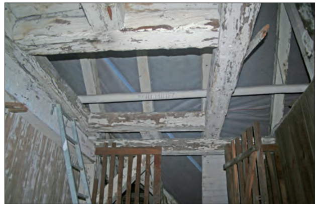
Abb. 12 Greifswald, Lange Straße 82. Windeluke im Oberdach des Vorderhauses. Ein Lastenaufzug diente dem Transport von Waren innerhalb des Gebäudes. Zu ihm gehörten solche Windeluken, die ursprünglich auch in den übrigen Geschossdecken vorhanden waren. Blick nach Norden. Foto: D. Brandt (2014)
