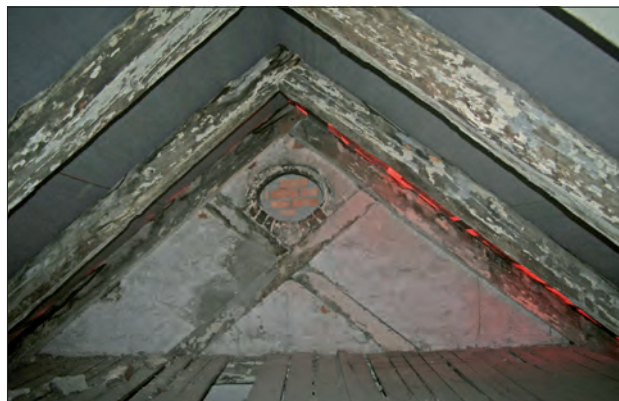
Abb. 14 Greifswald, Lange Straße 82. Blick auf die Spitze des Ostgiebels. Dieser Giebel des Vorderhauses wurde - anders als jener auf der Gegenseite und die übrigen Umfassungsmauern - nicht durchgehend massiv, sondern als verblendetes Fachwerk errichtet. In seiner Spitze sind das für die erste Hälfte des 18. Jahrhunderts typische Andreaskreuz und ein liegendes Ochsenauge zu erkennen. Foto: D. Brandt (2014)
