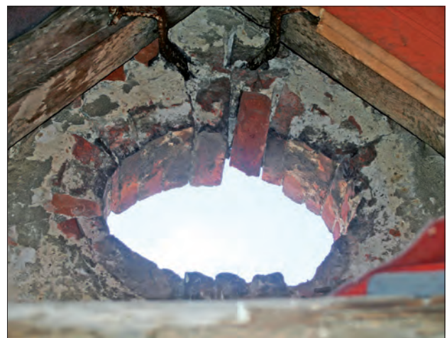
Abb. 17 Greifswald, Lange Straße 82. Oberdach des Seitenflügels von 1788/1789. Innenansicht der nördlichen Giebelspitze. Ähnlich wie in beiden Giebeln des älteren Vorderhauses gibt es auch hier ein quer liegendes Ochsenauge. Blick nach Norden. Foto: D. Brandt (2014)
